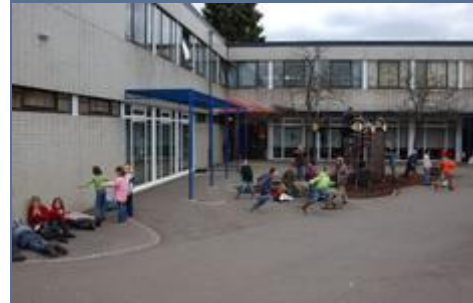
Das Gebäude der Städtischen Französischen Schule ist in einem derart schlechten Zustand, dass nach der Verlagerung des Schulbetriebs zur Monschauer Straße nur noch ein Abriss in Frage kommt.
